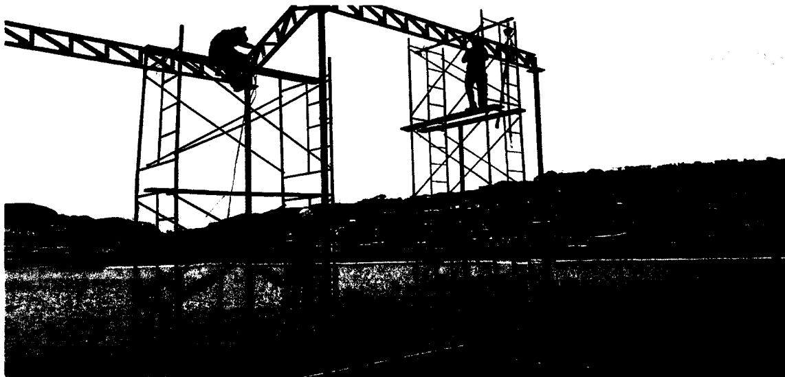
FOTO N°002 – Montaje de Estructura RFI N°01
