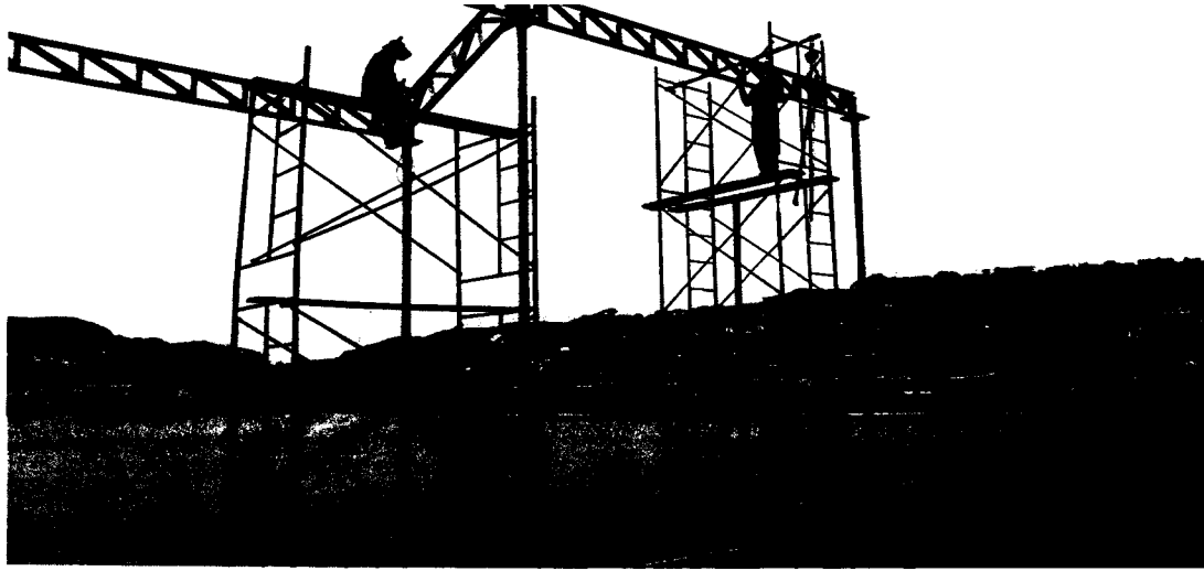
Imagen N° 5 Montaje de plataforma baja
