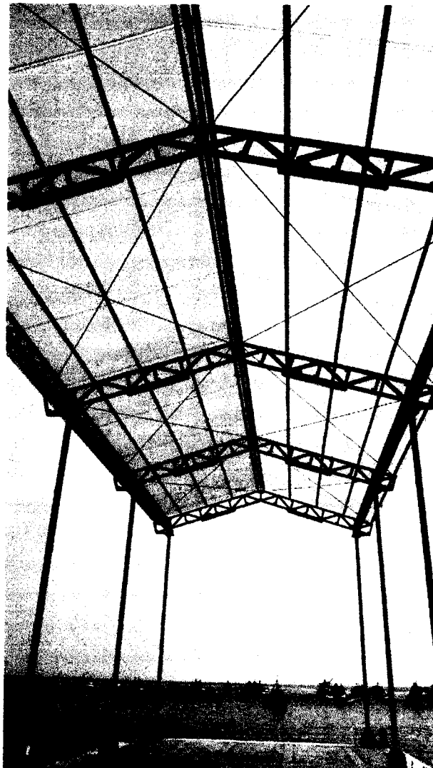
IMAGEN 08 Colocación de templadores.
