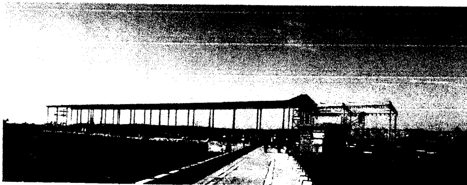
IMAGEN 03 Fotografía panorámica de cobertura antes de la instalación del policarbonato en plataforma baja.
